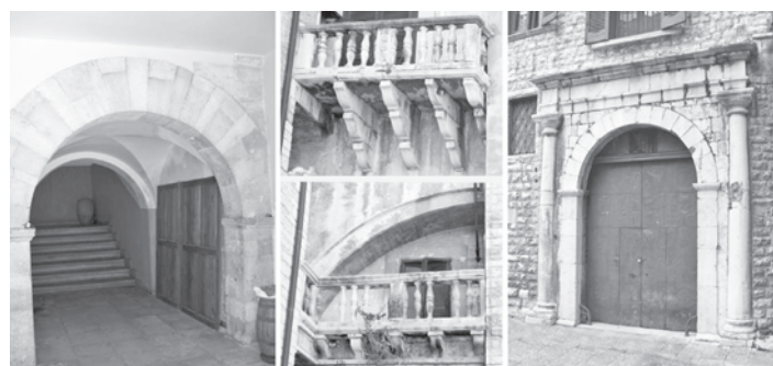
Antiche vestigia (probabilmente) del palazzo dei Del Balzo: l'ingresso alla primitiva scala Nord, i balconi della "cerniera" di aggancio alla Cattedrale e il portale interno sul lato est del cortile.
