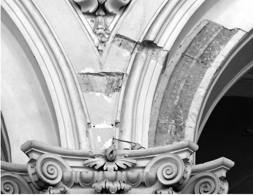
Fig. 1) Andria, Basilica di Santa Maria dei Miracoli, navata sinistra. Saggio al disopra del capitello del terzo pilastro a sinistra della navata principale. E' ben visibile la struttura lapidea degli archi, dipinti a vivi colori.
